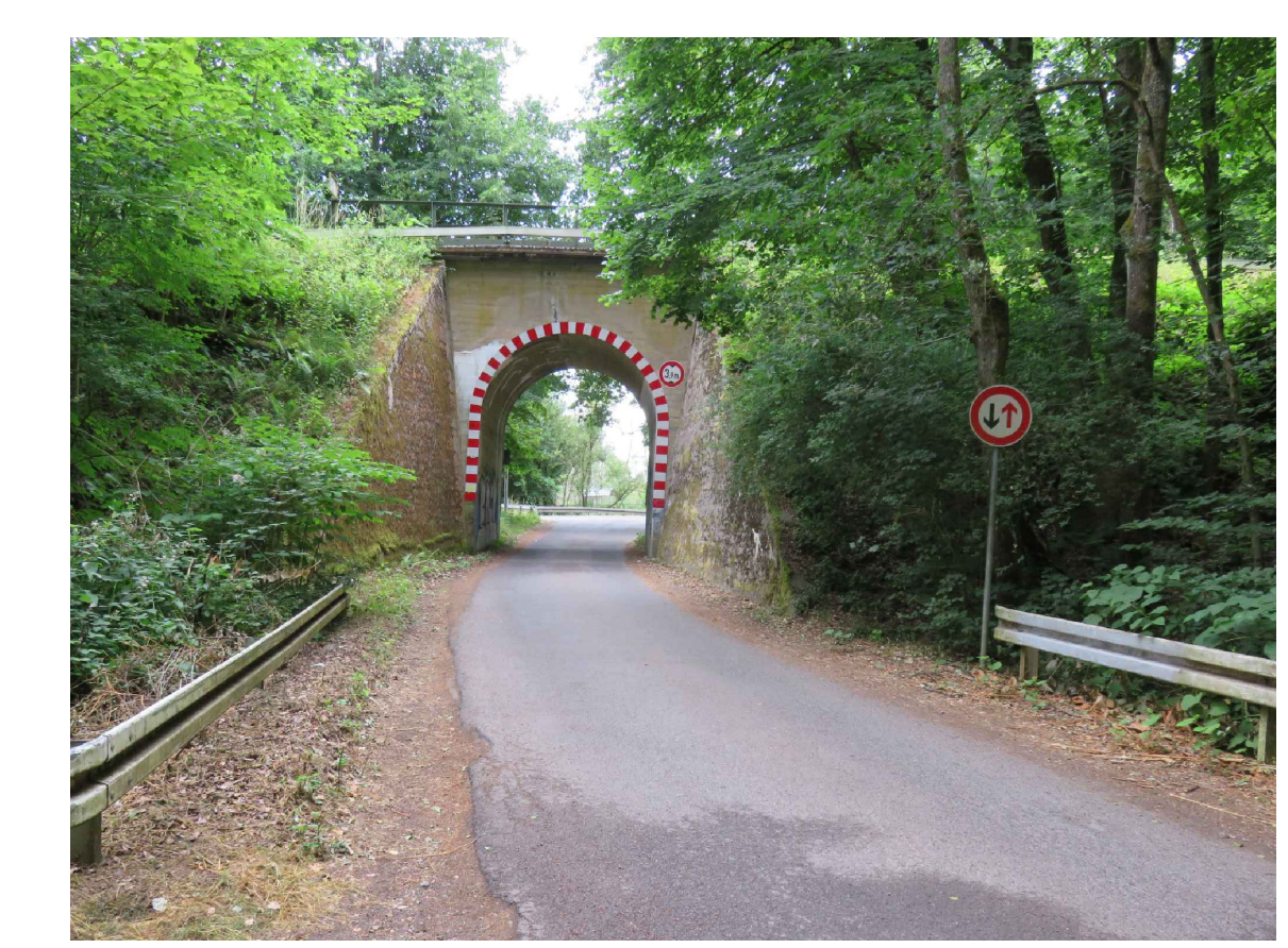
Abb. 2: Zufahrt Richtung L 111 Aufnahme datum: 28. Juni 2023
